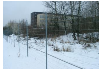
4. ábra Érzékelőkábel elrendezés keretezett, fonott dróthálóra
