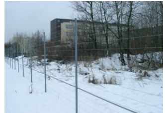
4. ábra Érzékelőkábel elrendezés keretezett, fonott dróthálóra
