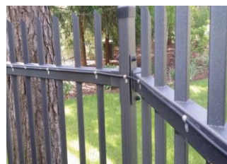
15. ábra Érzékelő kábel elrendezés téglá oszlopok közötti fa kerítésre
